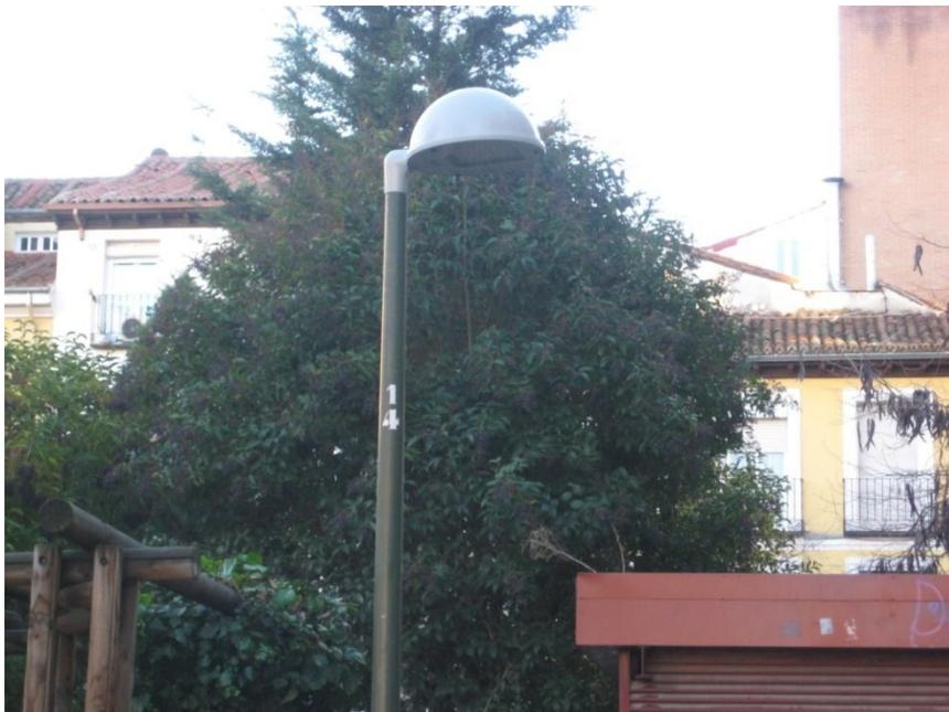
Imagen del globo hemisférico de leds que sustituye a los de tipo esférico en parques y paseos. Todas las luminarias de leds de Madrid son de Philips.
