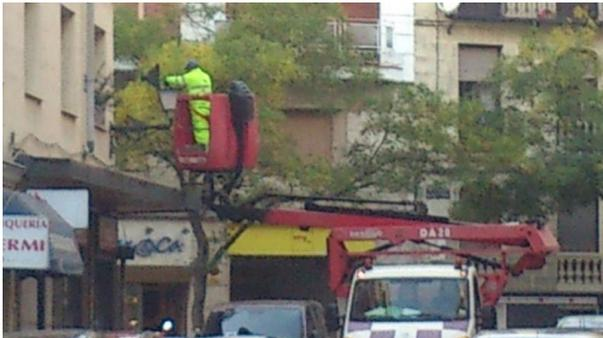
Operación de sustitución del grupo de iluminación con lámpara de sodio por un panel integrado de leds. La operación se realiza sin desmontar siquiera el farol.
