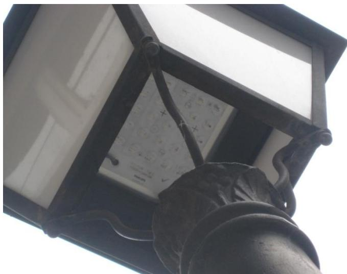
Imagen interior de un panel integrado de leds colocado en un farol viejo dotado anteriormente con una lámpara vertical de sodio de 150 vatios. La potencia de este panel de leds de 71,5 vatios puede leerse justo encima de la marca Philips.
